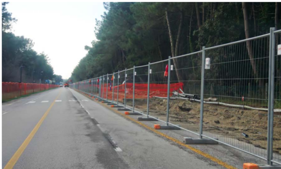
Uno dei cantieri del rigassificatore FOTO MASSIMO FIORENTINI
